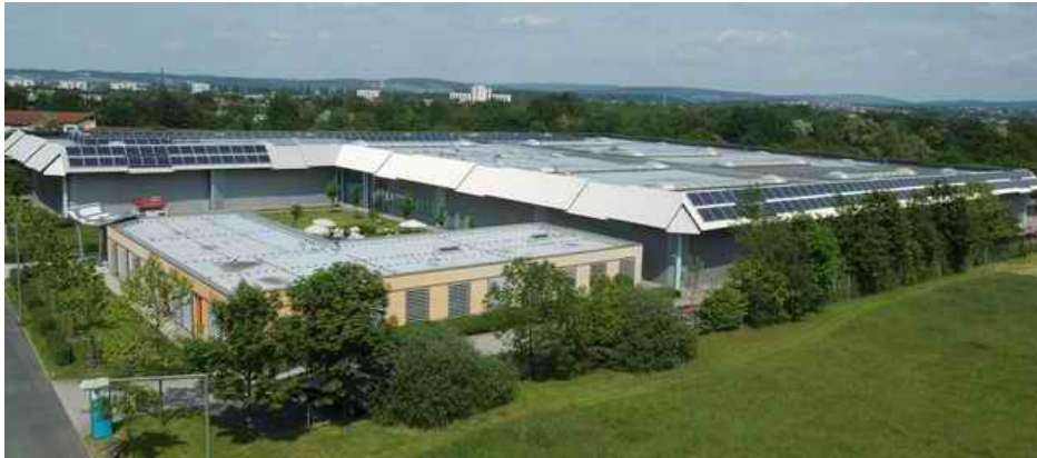
Abbildung 7: 100-kWp-Photovoltaikanlage auf dem Hallendach der Hübner GmbH
