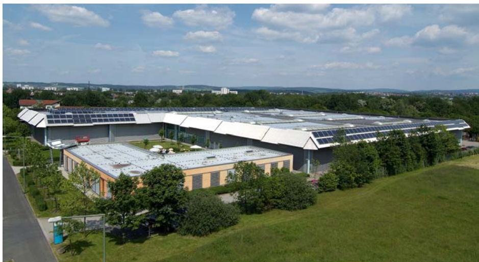
Abbildung 18: Industriebetrieb zum Test des Multi-PV Prototypen mit einer 100 kW p -PV-Anlage
